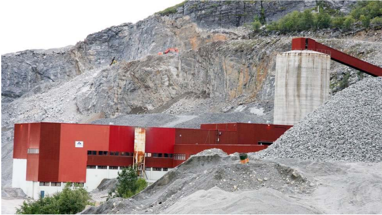
Gruveanlegget til Nussir i Repparfjorden. FOTO: ARKIV
