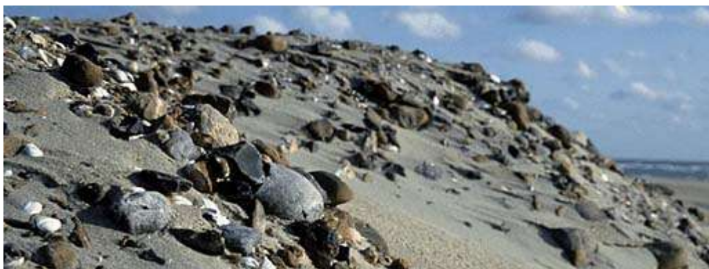
Bilde 4: Dike umiddelbart etter påføring av sugemudrede masser.
